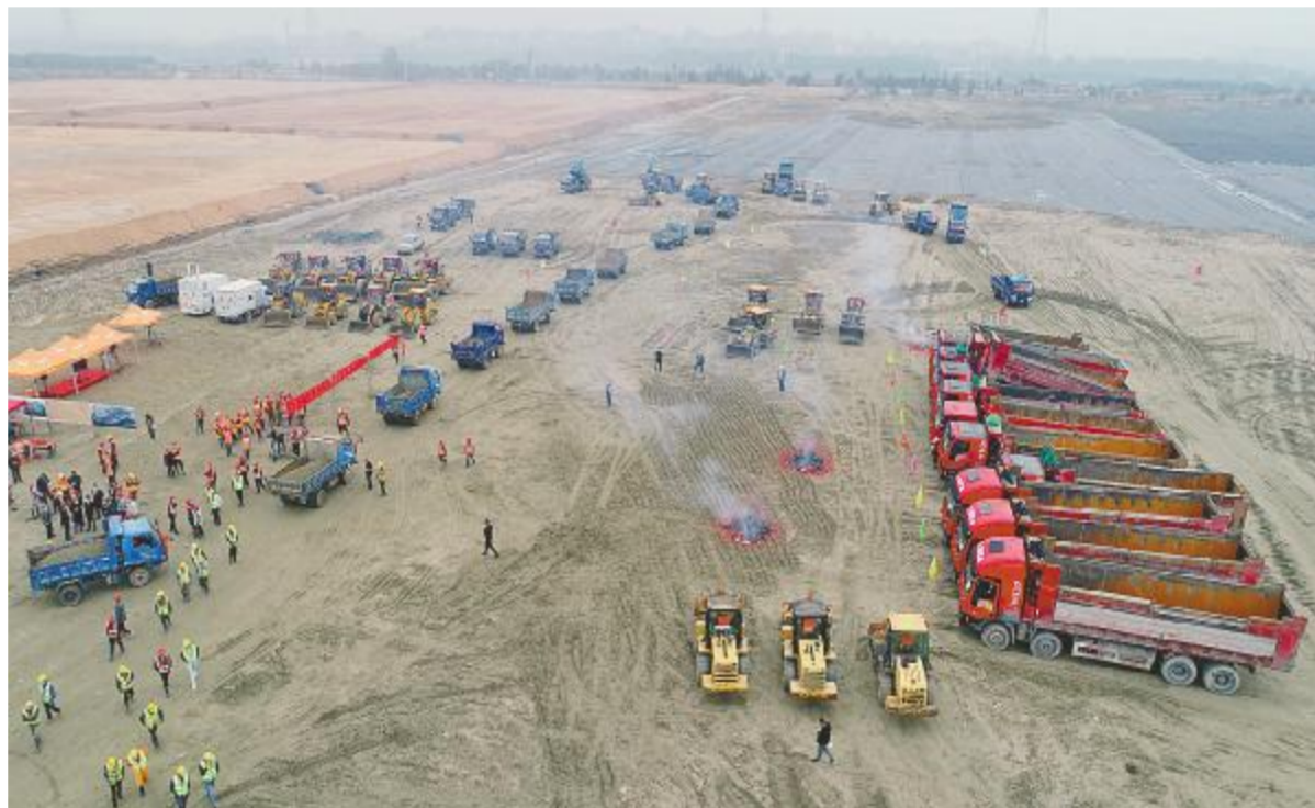
秀屿区石门澳化工新材料产业园规划面积 8.4 平方公里,已建成项目 2 个,正在建设项目 3 个,还有签约项目 2 个,整个产业园总投资将超过 700 亿元。近日,产业园基础设施项目先行开工。图为开工现场。
