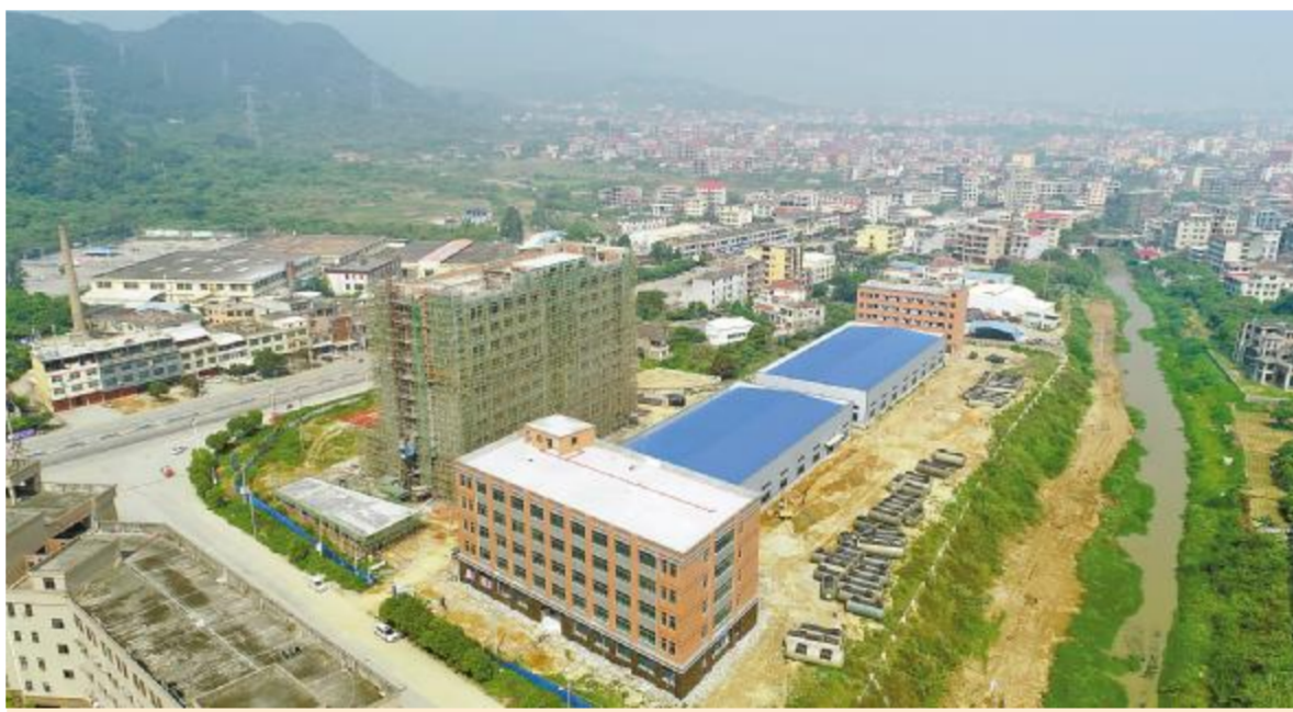
图为天海石油行业配套产业基地项目建设现场。 本报记者 林罗晓 摄
