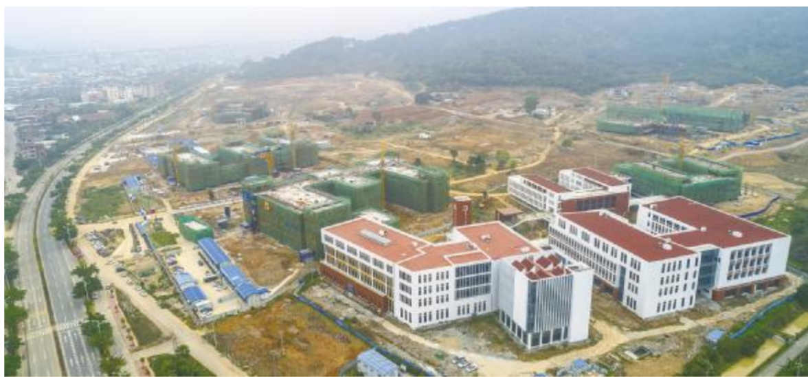
图为湄职院新校区加快建设。
