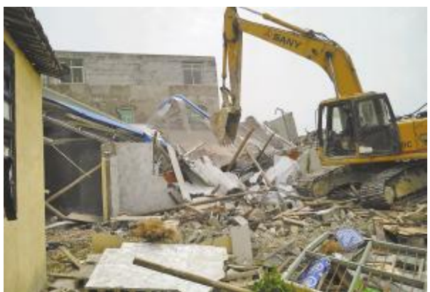
图为拆除违章建筑物现场。
