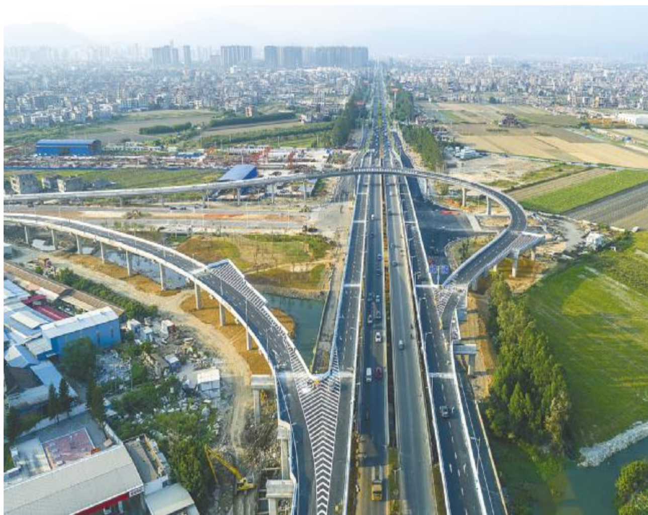
图为沈海高速黄石出口互通提升工程完工,车辆通行更顺畅。本报记者 陈斌 摄
