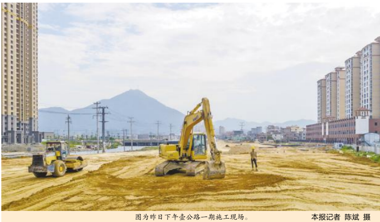
图为昨日下午壶公路一期施工现场。
