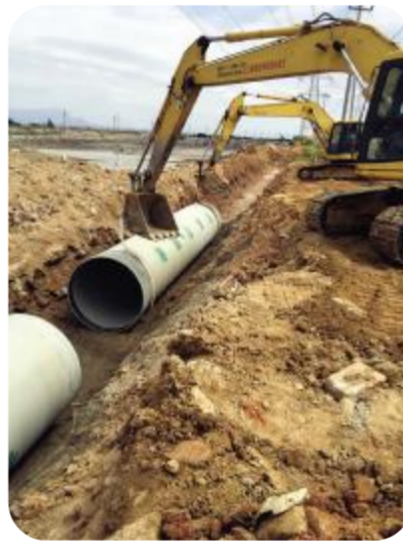
金钟水利枢纽引水配套工程 石门澳支线铺设管网
