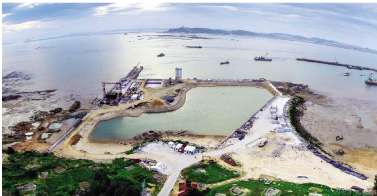
湄洲岛一级渔港项目建设全力推进
